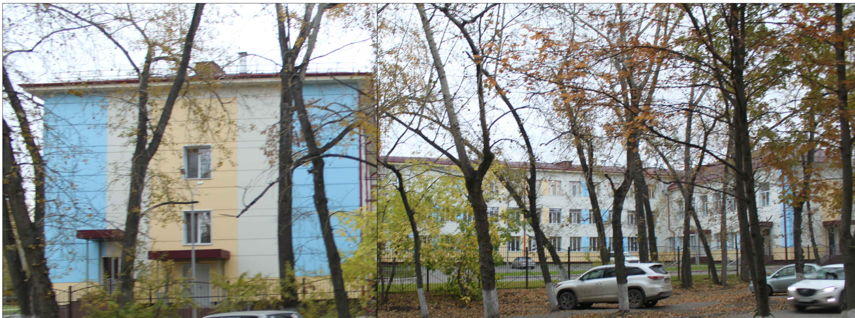
Материалы фотофиксации существующего состояния фасадов. Боковой фасад в осях 1-13
