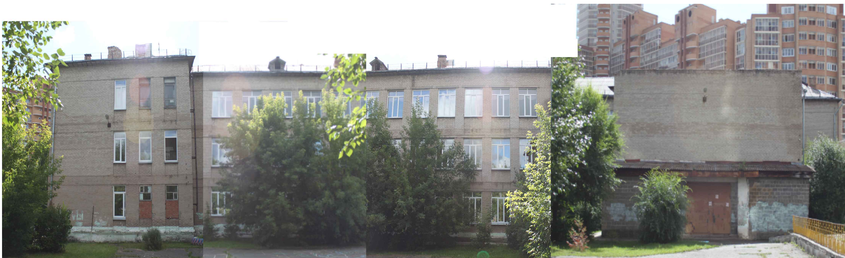
Фрагменты дворового фасада в осях 2 -1.
