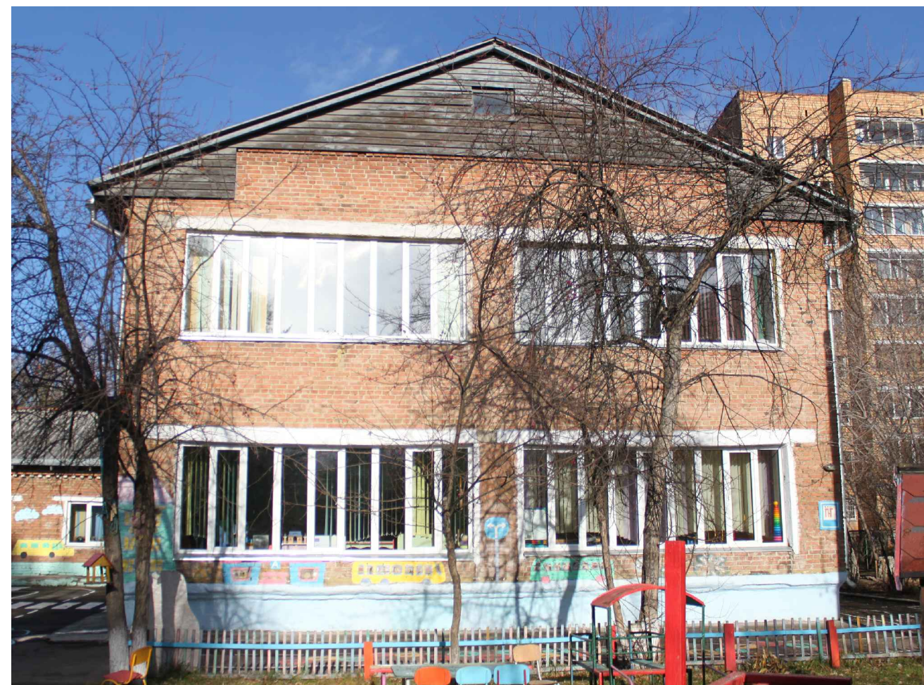
Фрагмент фасада в осях 3-4
