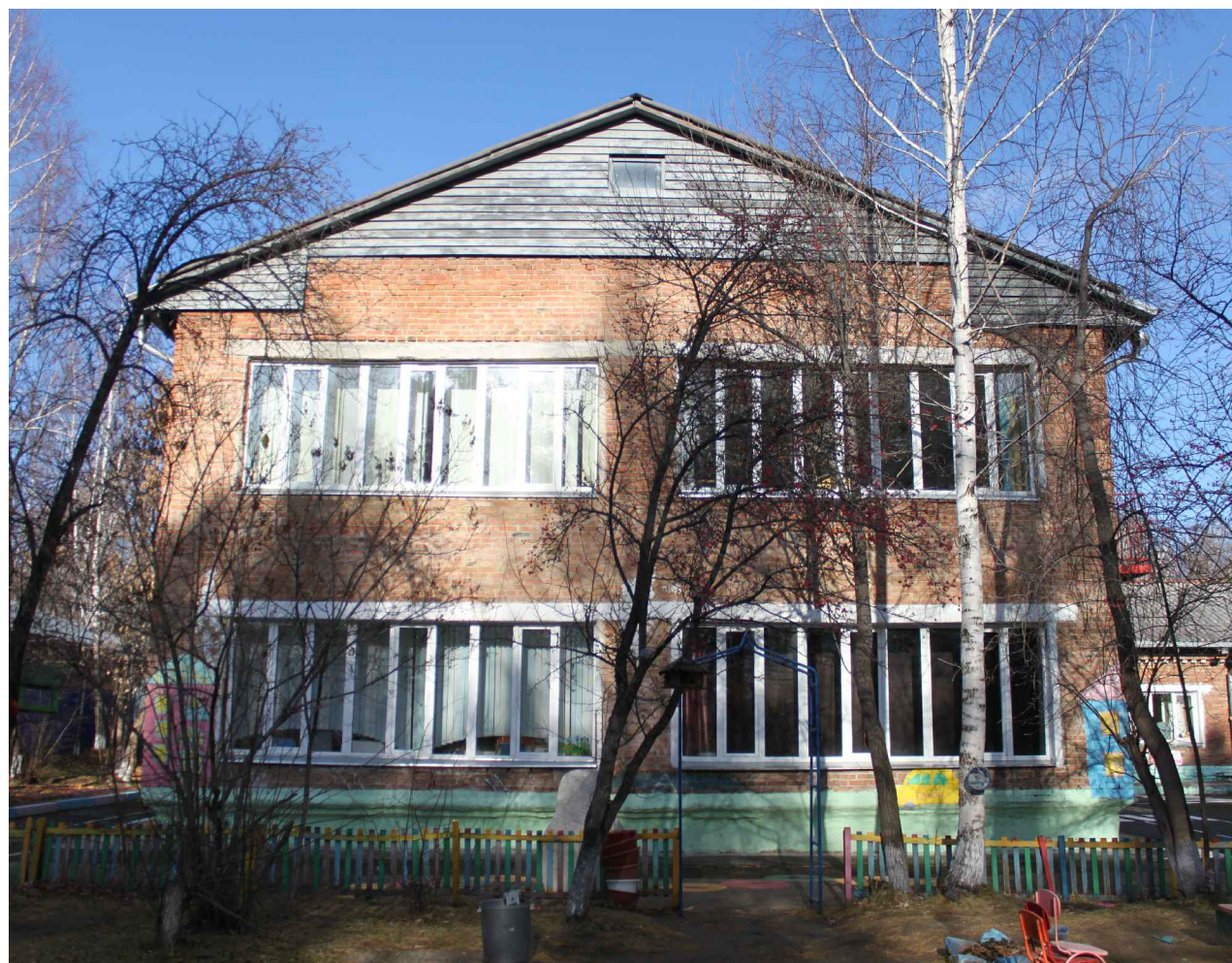
Фрагмент фасада в осях 1-2
