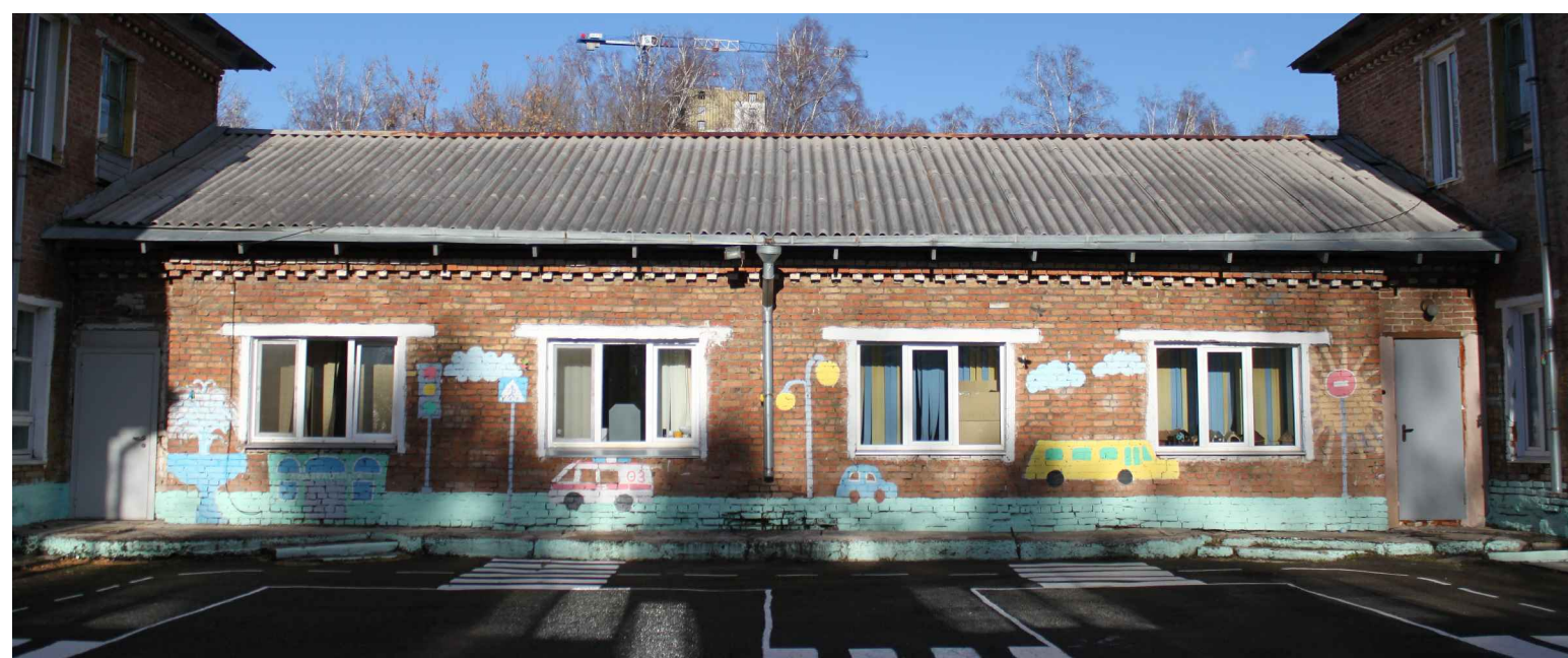
Фрагмент фасада в осях 2-3
