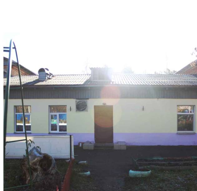
Фрагмент фасада в осях 3-2
