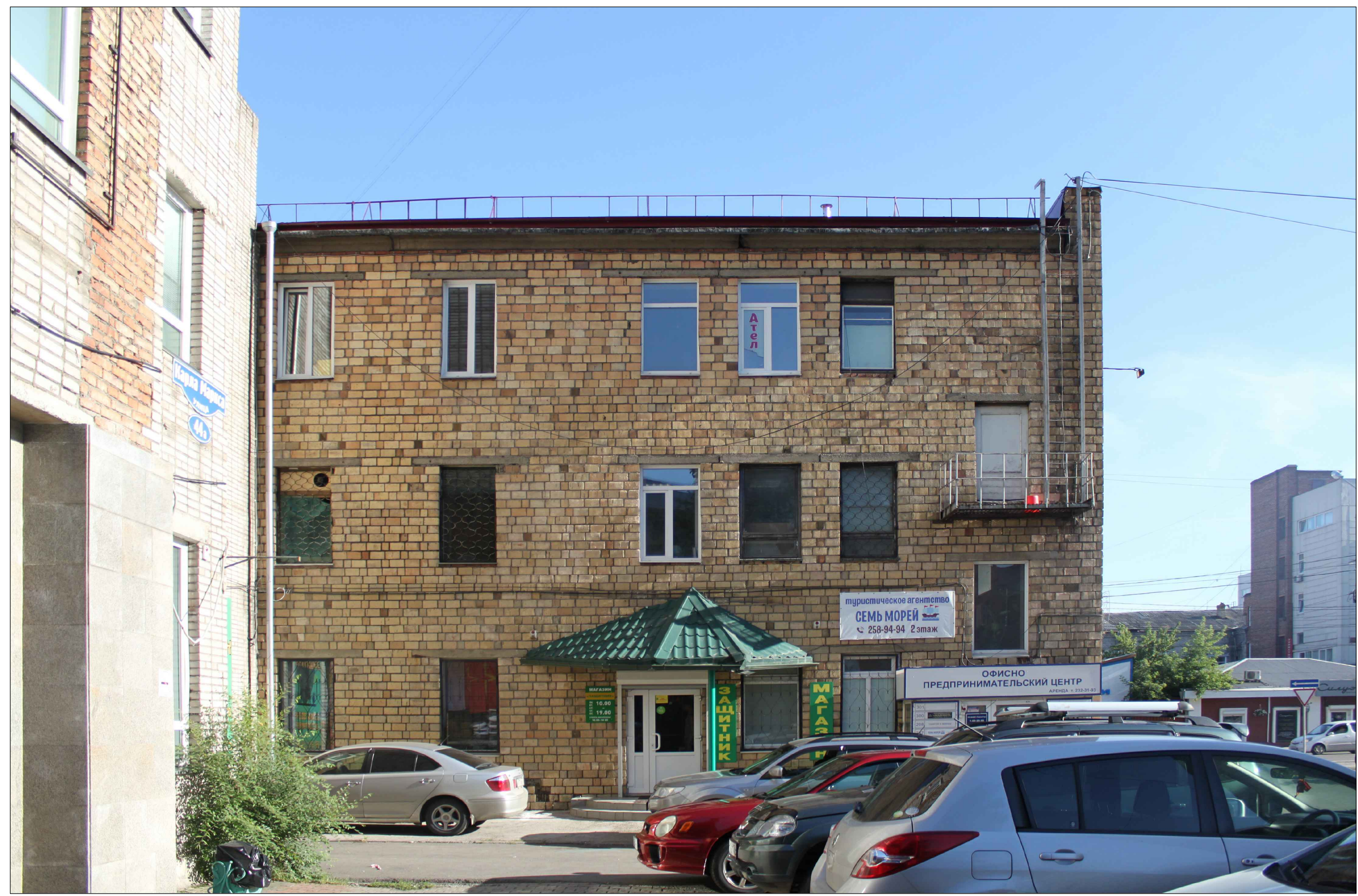
Материалы фотофиксации существующего состояния фасадов. Дворовой фасад в осях 2-1
