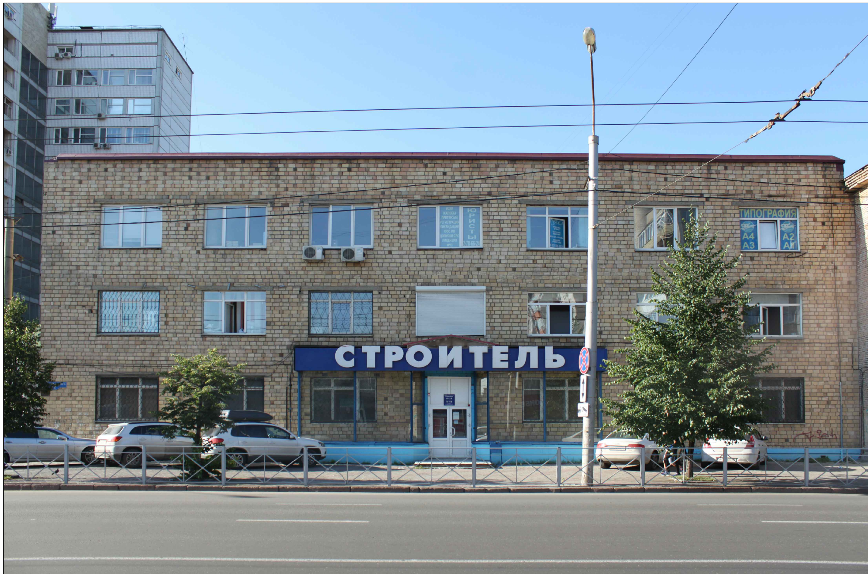
Материалы фотофиксации существующего состояния фасадов. Главный фасад в осях 1-4
