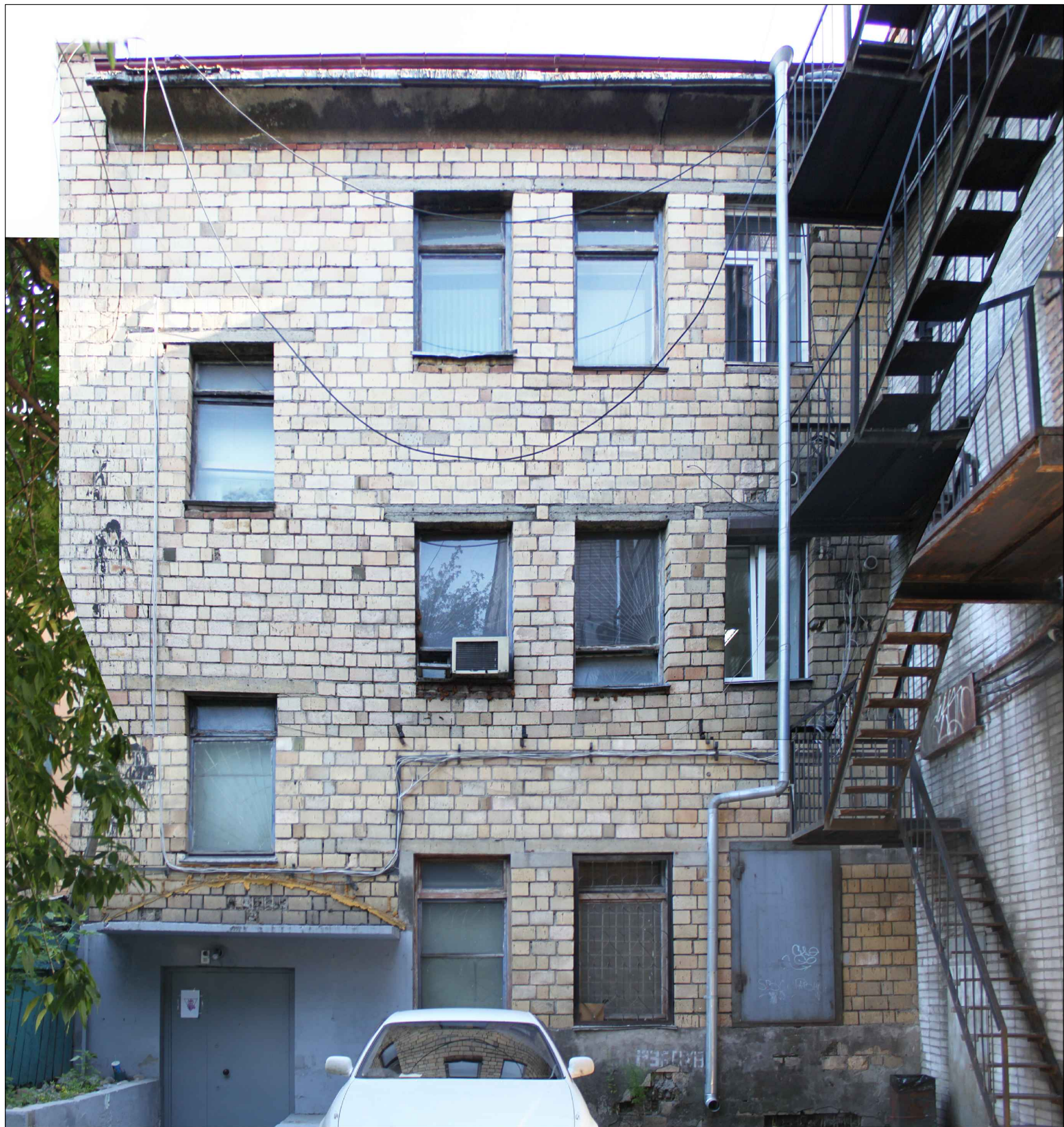
Материалы фотофиксации существующего состояния фасадов. Дворовой фасад в осях 4-3
