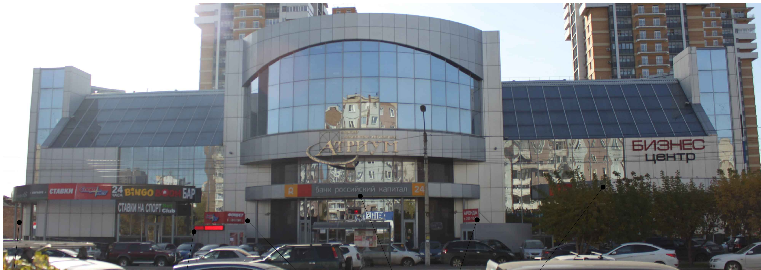
Материалы фотофиксации существующего состояния фасадов. Главный фасад в осях 11-1
