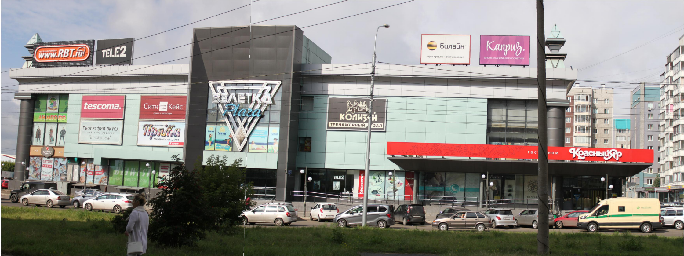
Материалы фотофиксации существующего состояния фасадов. Боковой фасад в осях А-Б
