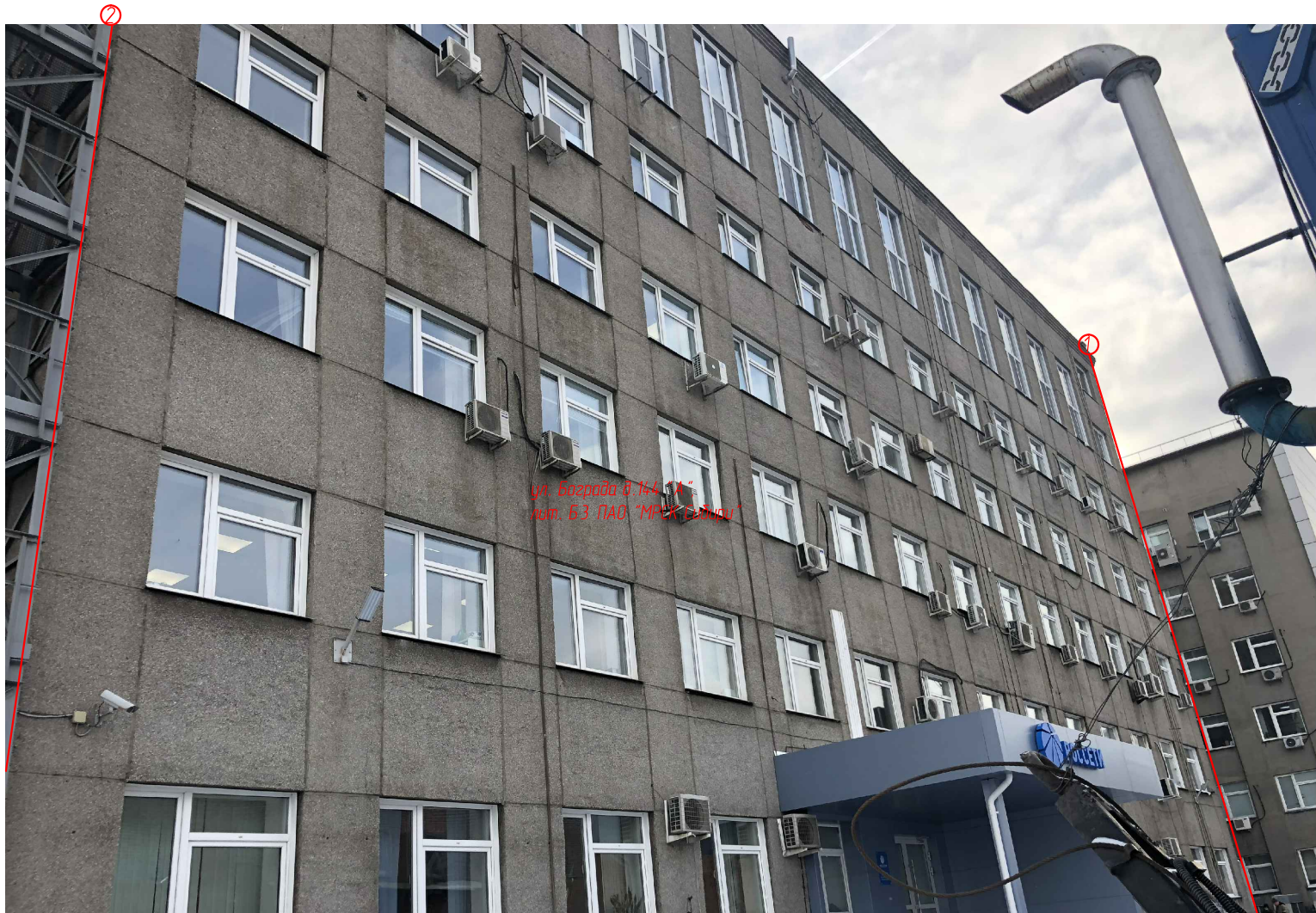
Главный фасад в осях (2-1 БЗ)
