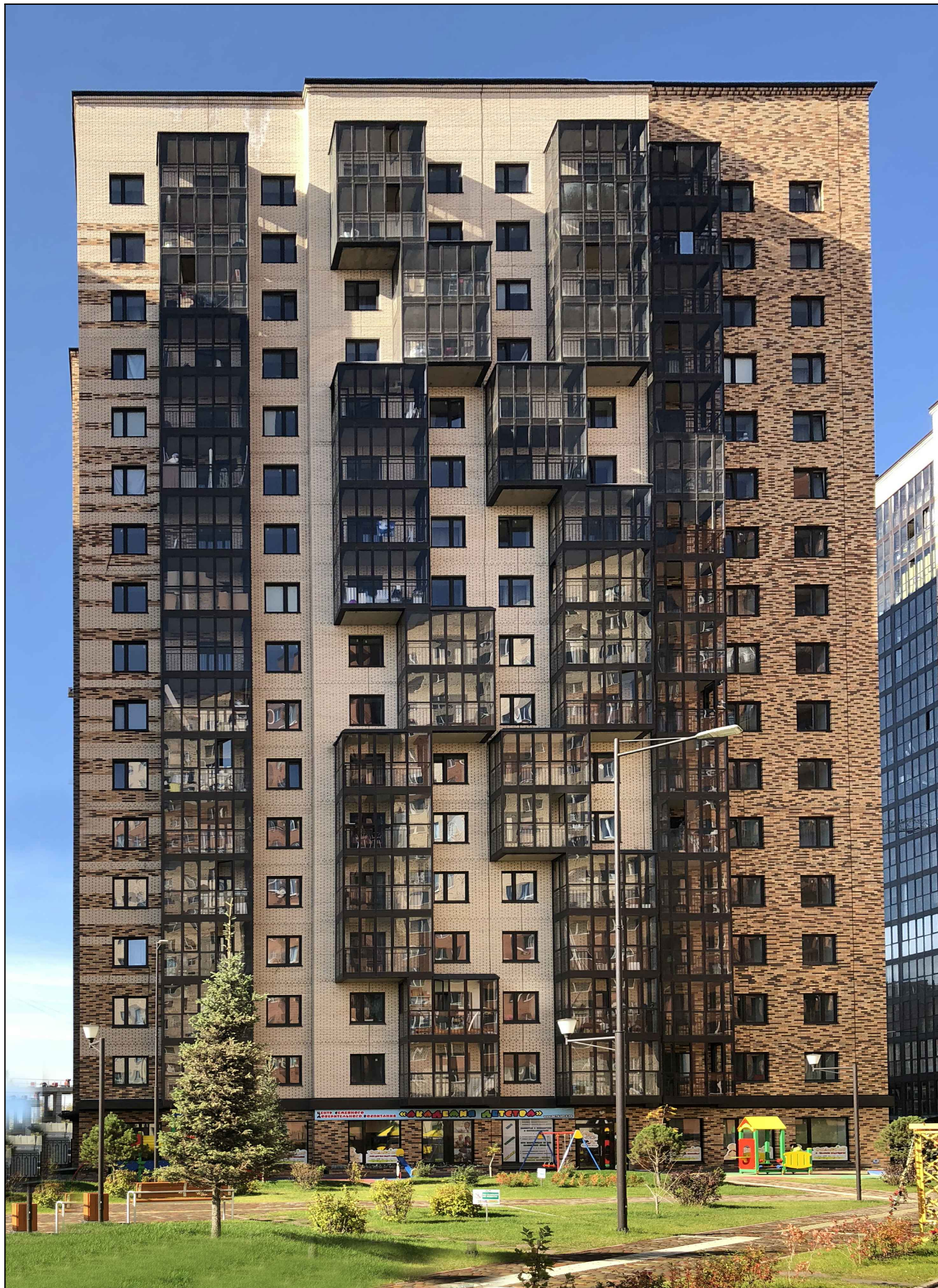
ДВОРОВОЙ ФАСАД - ВОСТОЧНЫЙ (со стороны ул. Шахтеров)
