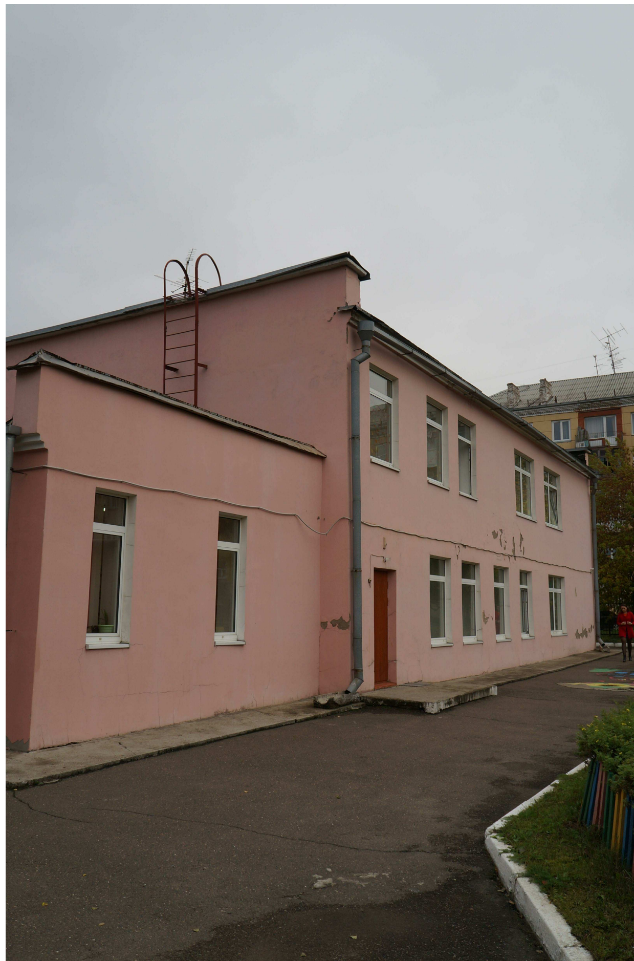
Фотофиксация бокового (юго-западного) фасада
