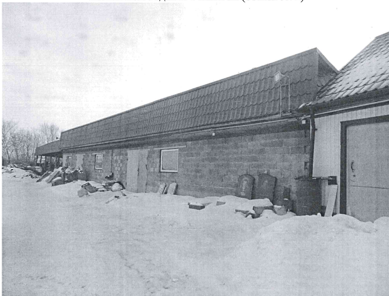
Капитальное здание с навесом (объект № 2)
