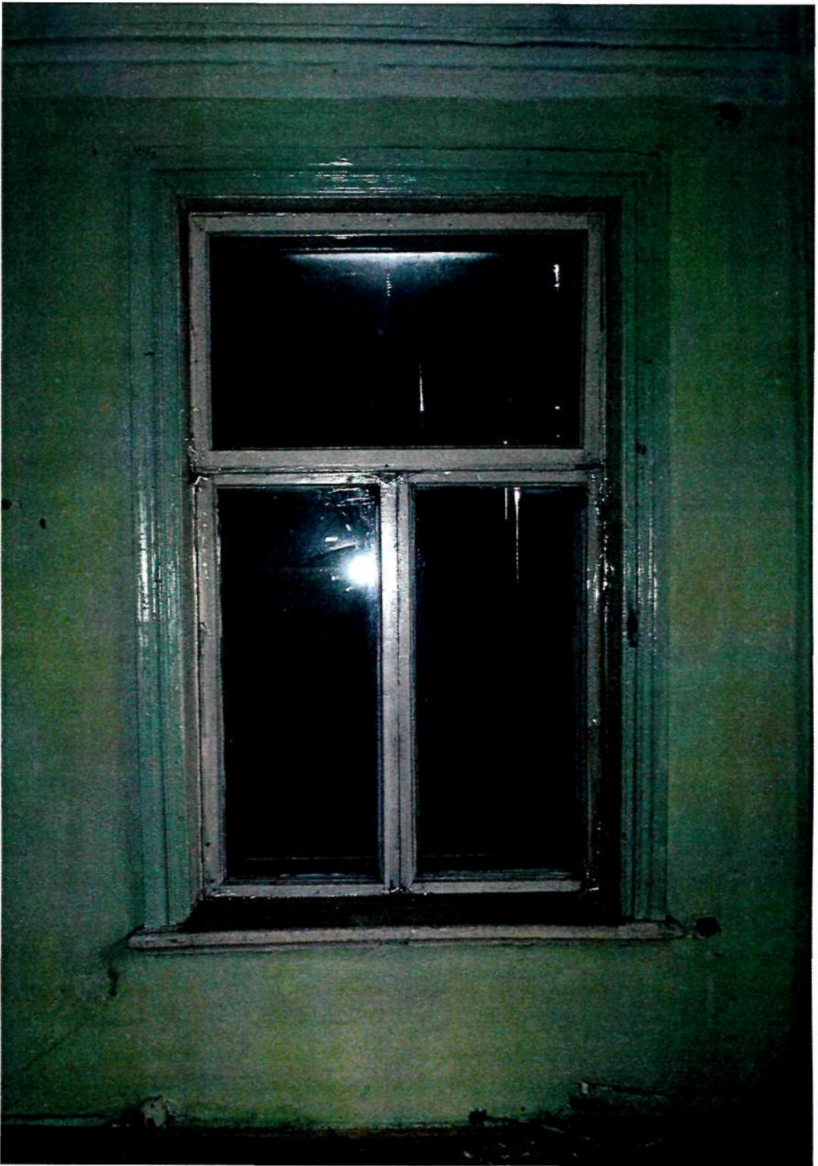
Фото 15. Интерьер; стандартные профилированные наличники оконных проемов жилых комнат объекта
