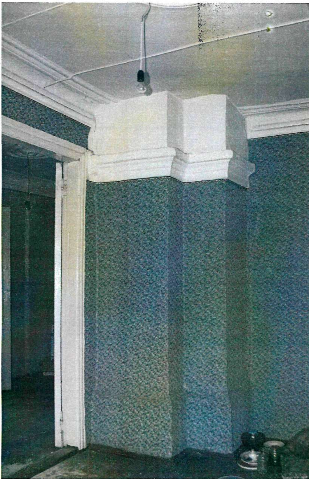
Фото 23. Интерьер второго этажа; печной блок в комнате, соответствующе й второй оконной оси северного фасада
