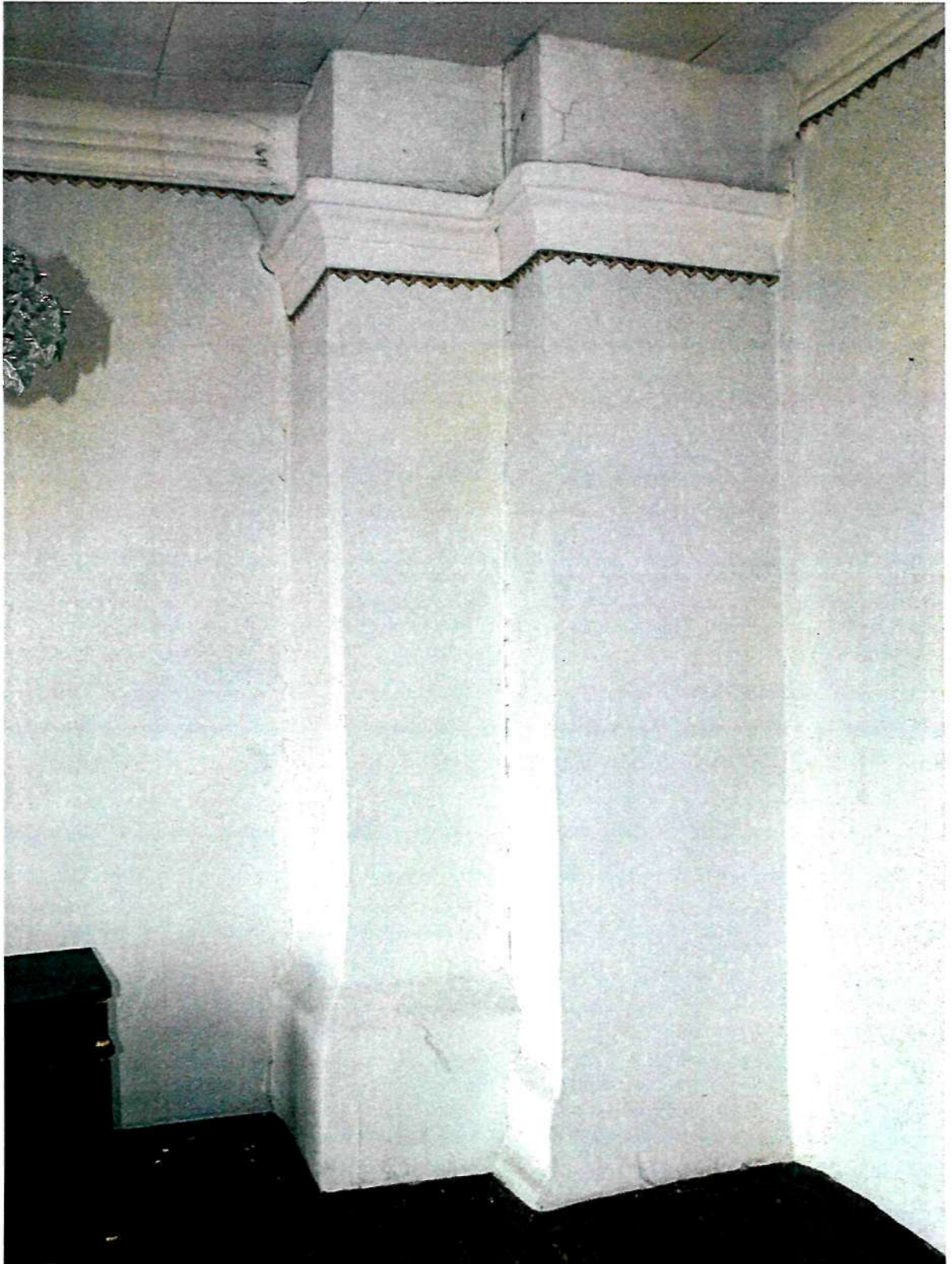
Фото 24. Интерьер второго этажа; печной блок в комнате, соответствующей третьей оси восточного фасада
