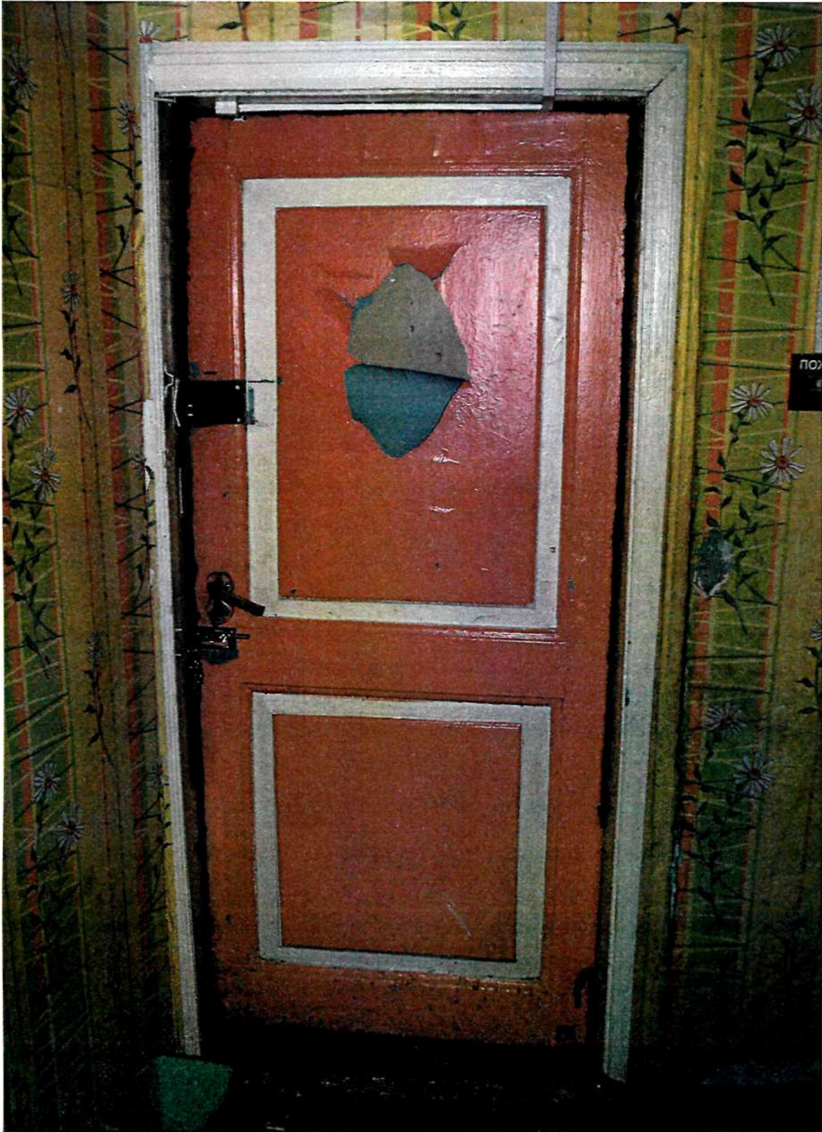
Фото 10. Дверь (тип 2) внутренняя однопольная филленчатая межкомнатная; всего в объекте сохранилось две аналогичные двери
