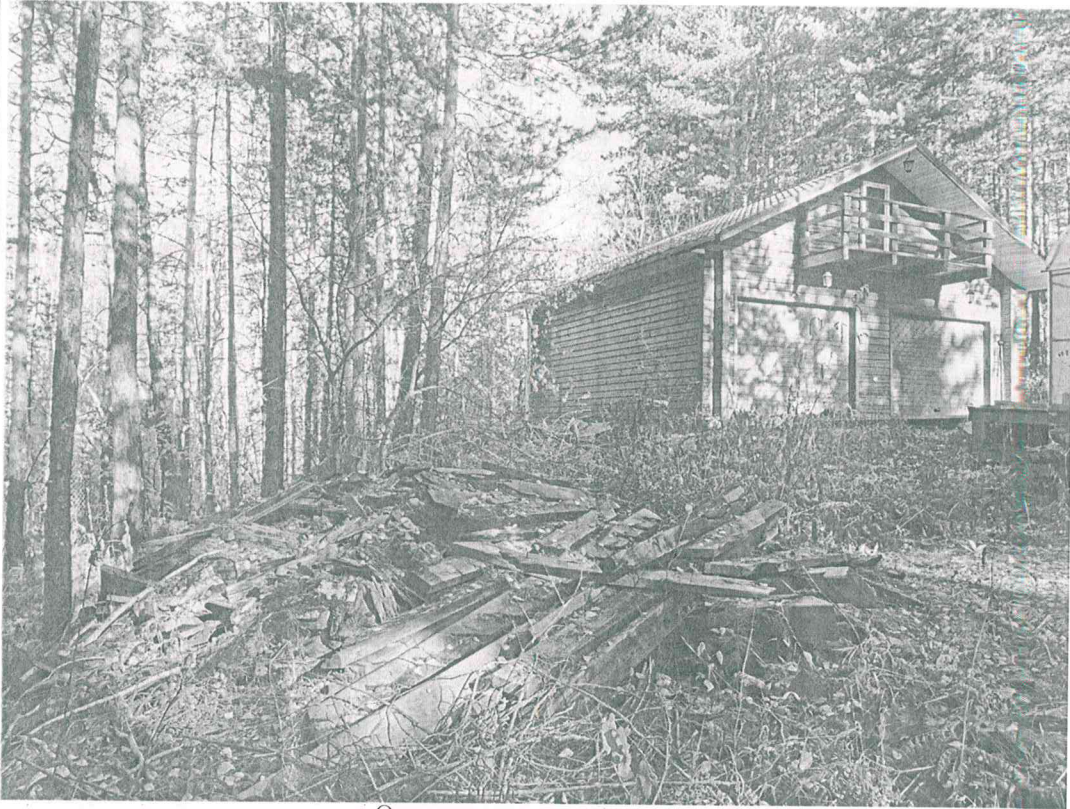
Одноэтажное деревянное строение
