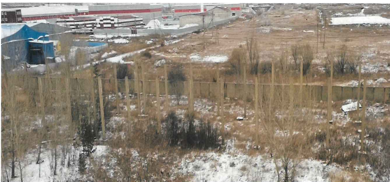
объект незавершенного строительства (объект 2)
