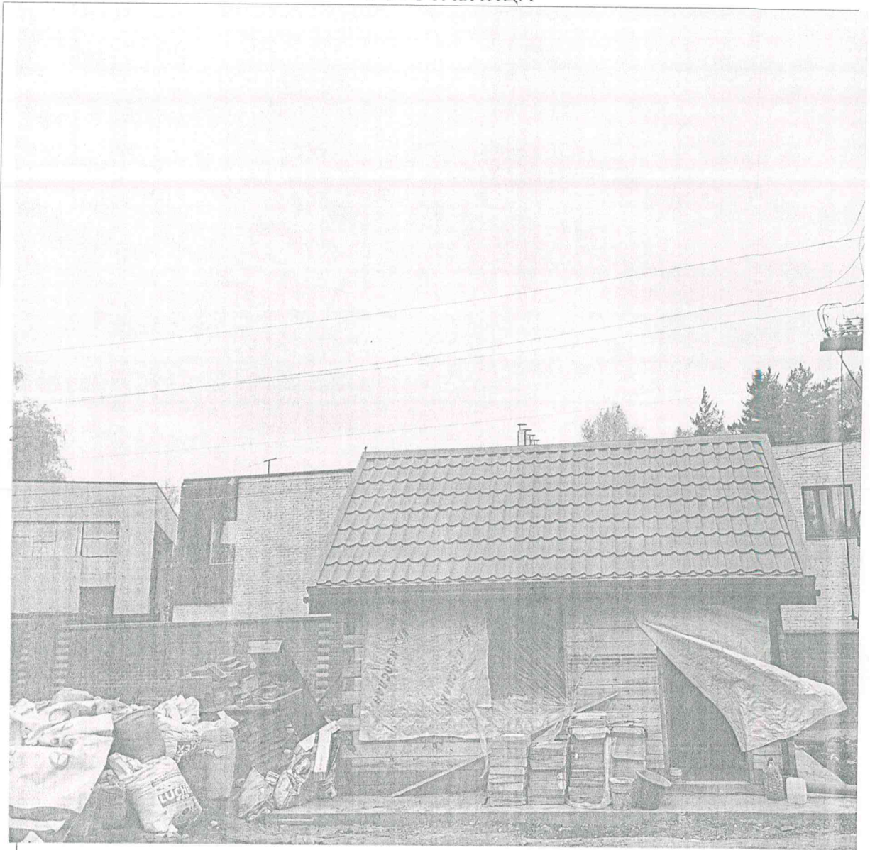
деревянное одноэтажное строение из бруса площадью застройки 16 кв.м. (объект № 2)
